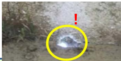
壁や床の破損がないか(外の光が漏れている所は要注意)
