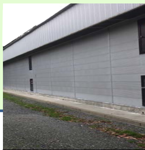
野生動物が隠れる場所を作らないように整理された鶏舎周辺
