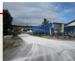
消石灰帯の設置
